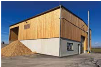
Foto: Heizwerk Hofmann
