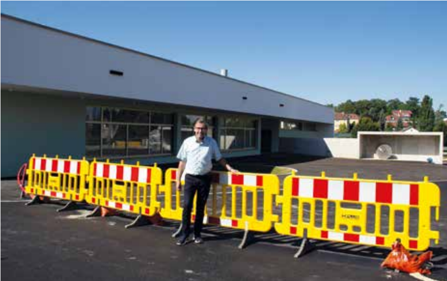
Bürgermeister Christian Deleja-Hotko überzeugt sich vor Ort vom Baufortschritt.
